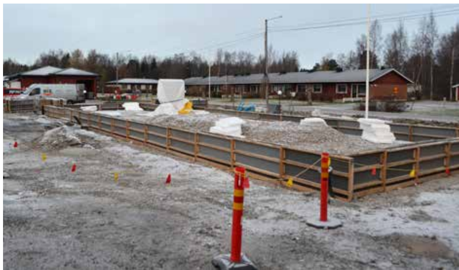
Sockeln är gjuten till det nya servicehuset, som ska stå klart sommaren 2017.
