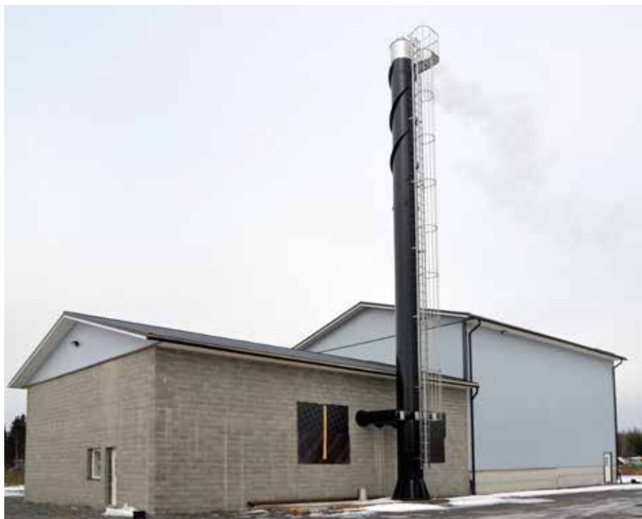
Den nya fjärrvärmecentralen finns på industriområdet i Korsnäs.
