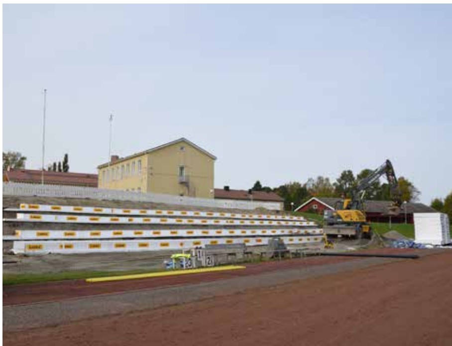
Läktarbygget vid centralidrottsplanen avancerar dag för dag.
