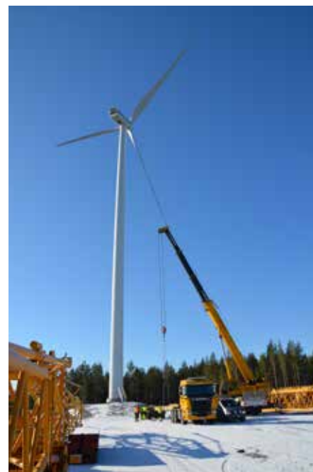
Två ståtliga vindkraftverk monterades på plats i mars 2017.
