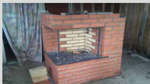
Pågående upp murning av en råspis.
