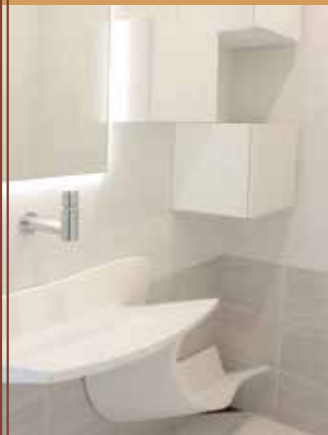
Kakel installation på alla väggarna
