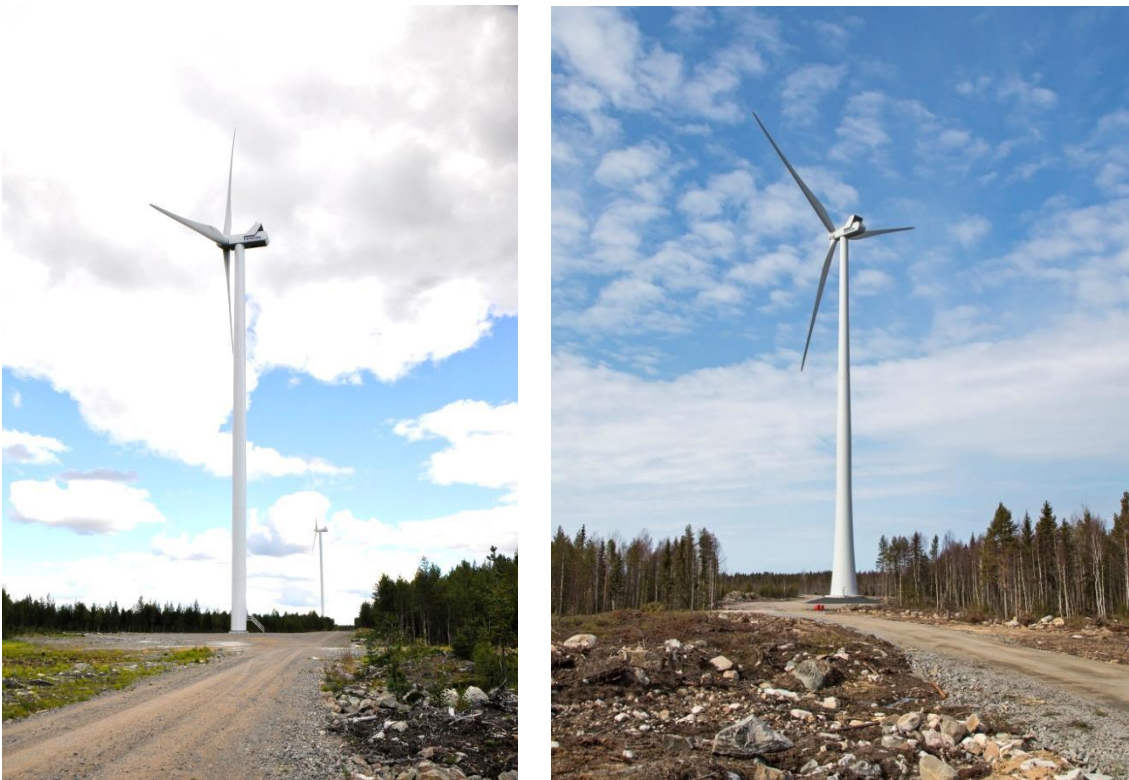
Kuva 2.9. Vasemmalla on esimerkki teräslieriötornista ja oikealla hybriditornista. (Kuvat: Leila Väyrynen ja Ville Suorsa, FCG)
