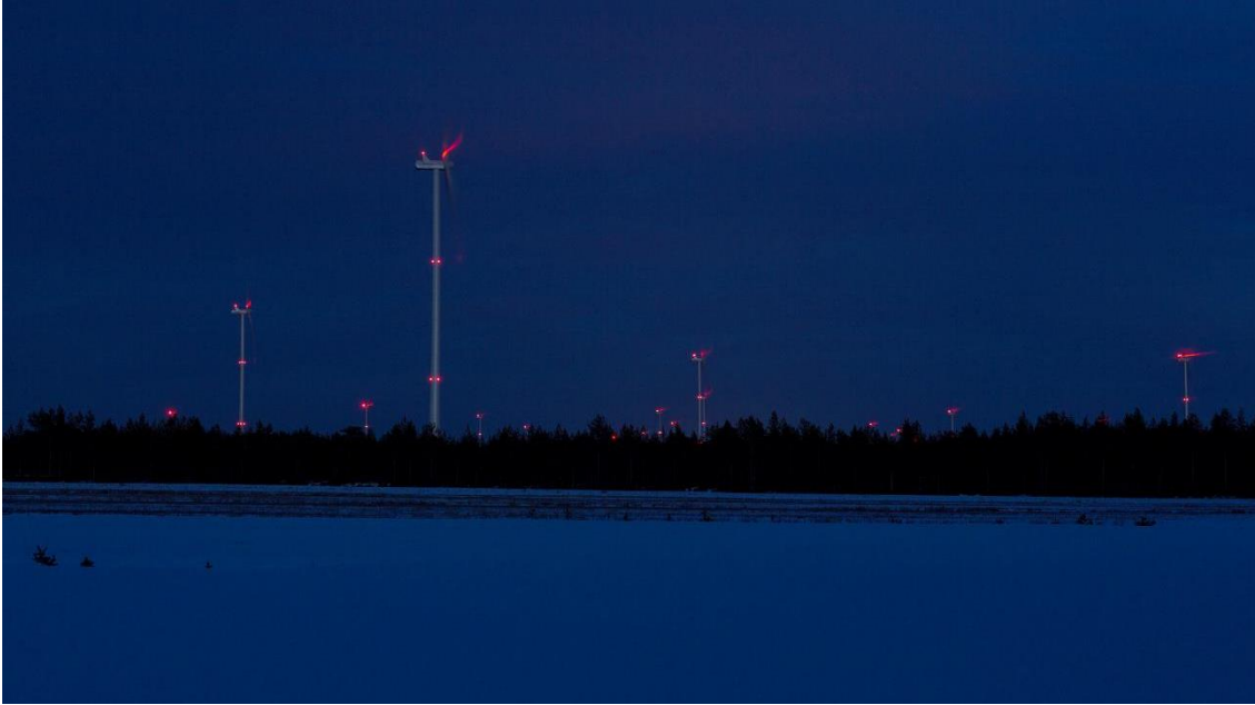
Kuva 2.11. Kiinteät punaiset lentoestevalot. (Kuva: Ville Suorsa, FCG)
