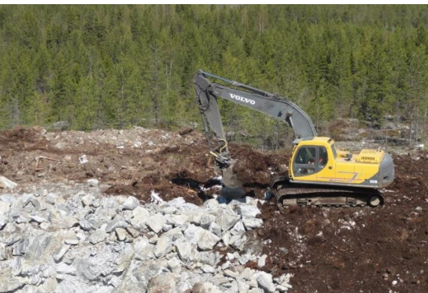
Kuvapari 2.14. Tuulivoimapuiston rakentaminen alkaa huoltoteiden ja pystytysalueiden rakentamisella (kuvat: Ville Suorsa, FCG).
