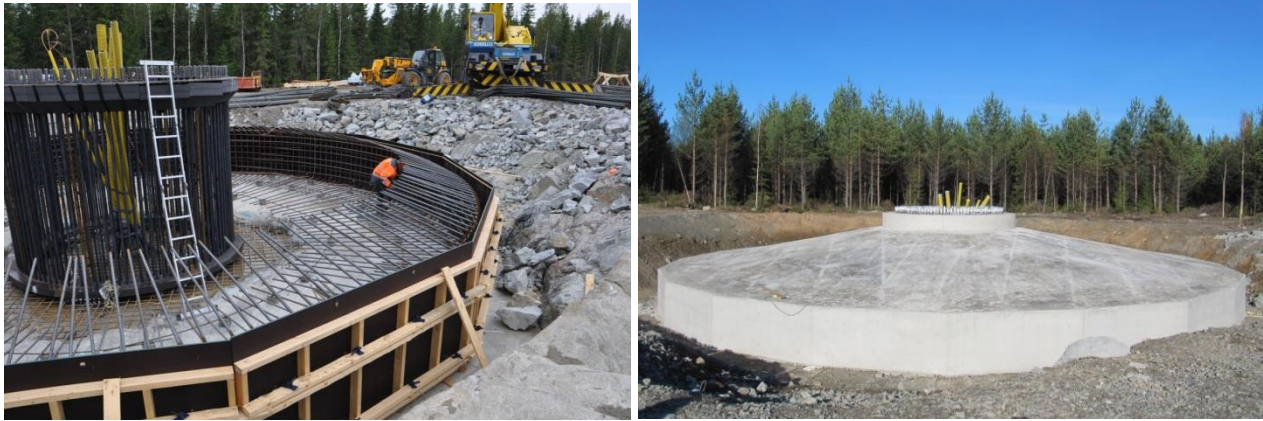
Kuvapari 2.16. Tuulivoimalan perustusten rakentamista. (Kuvat: Leila Väyrynen, FCG)
