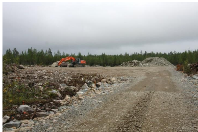
Kuvapari 2.14. Tuulivoimapuiston rakentaminen alkaa huoltoteiden ja pystytysalueiden rakentamisella (kuvat: Ville Suorsa, FCG).
