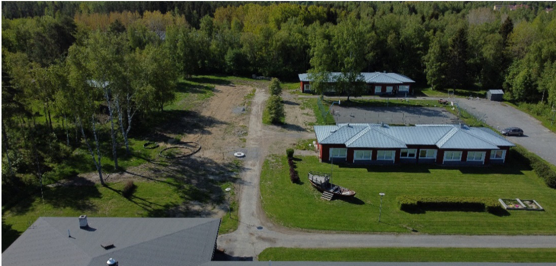
Bild 5. Radhustomten sett från norr, en tidigare radhusbyggnad har stått till vänster i bilden. Byggnaden kommer ersättas med ny byggnad.
