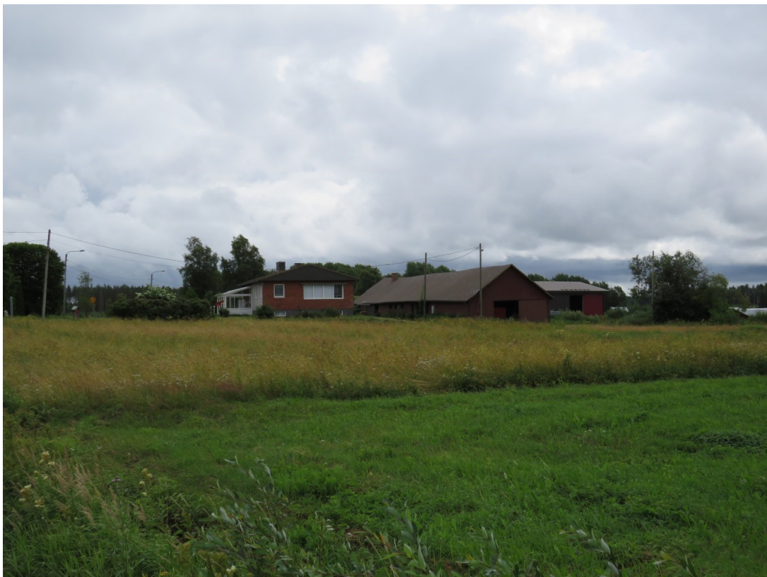
Byggnader på Västlunds gård fotograferat mot sydost.
