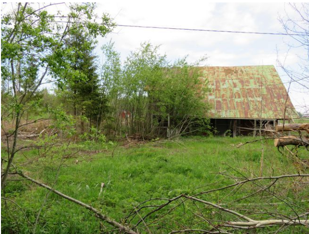
14. Kaapelireitti entisen sahan itäpuolella, länteen.
