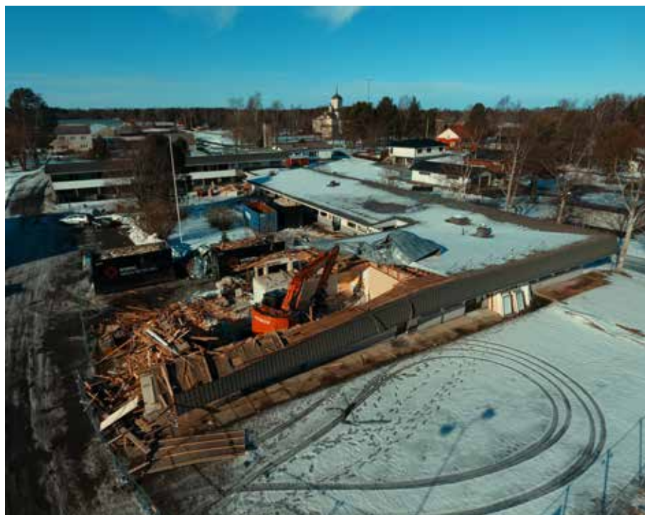
Rivningen av kommungården inleddes i början av mars och arbetet skall vara klart inom april månad.
